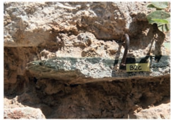
4 Plattenförmiger Phyllit in einer Horizontalfuge der Cella-Nordwand
