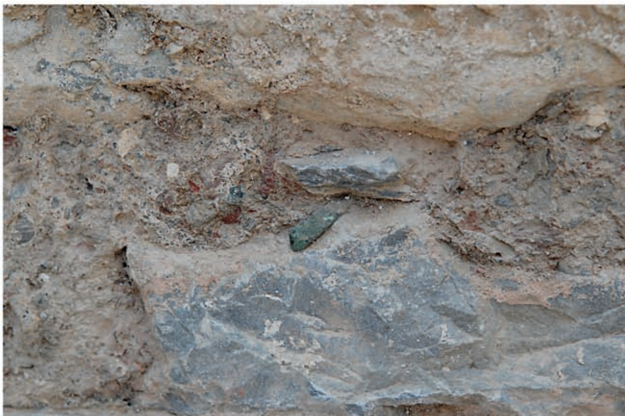
2 Mauerhaken im Bruchsteinmauerwerk der Cella-Ostwand, unterer Bereich
