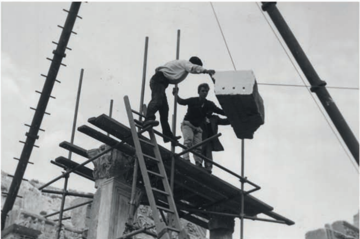
3 Wiederaufbau: Versatz von Architrav 029A; im unteren Bereich drei Bohrungen für die Aufnahme der Bewehrungsseisen des anschließenden Betongusses
