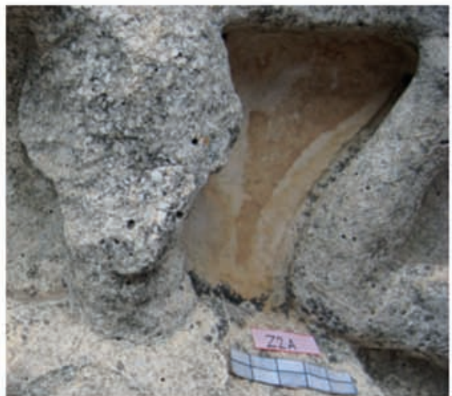
3 Rötliche Krustenbildung im Regenschattenbereich der Frieskopie 087Re
