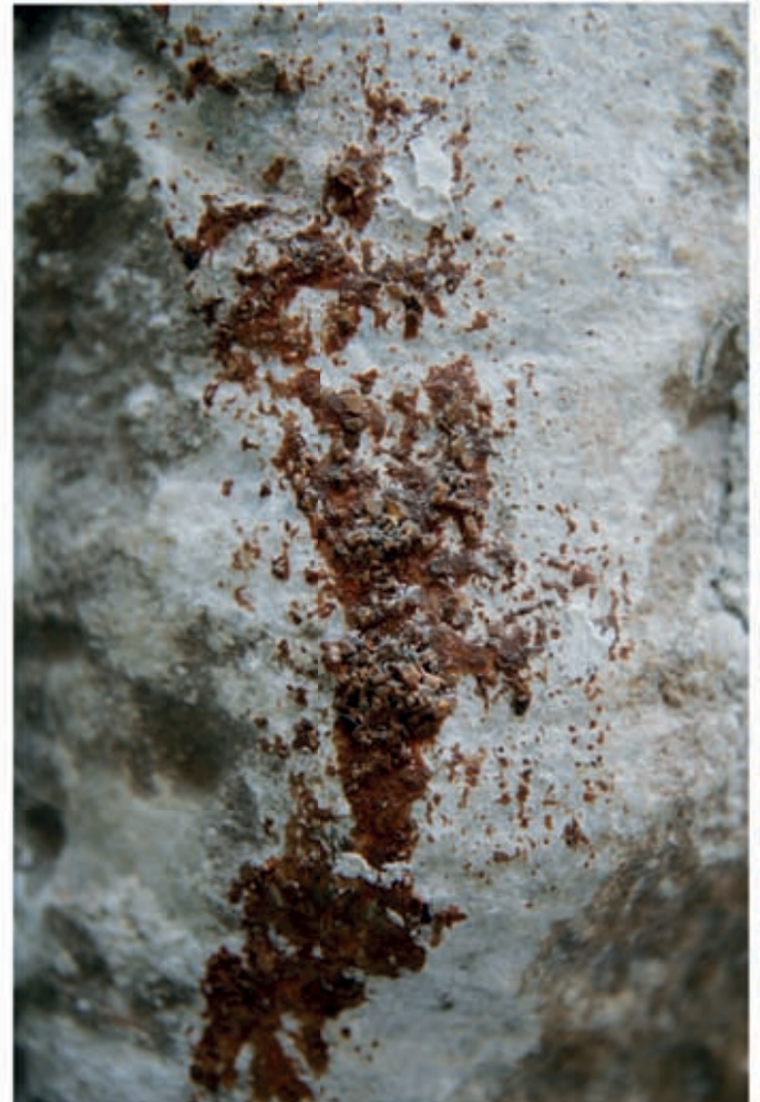
3 Verschmutzung der Friesoberfläche mit Farbe
