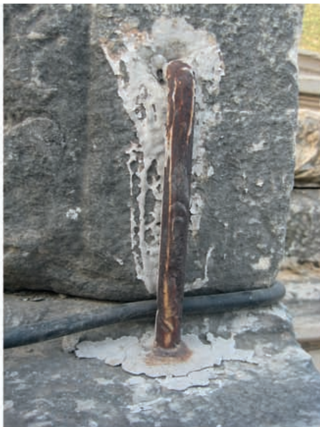
2 Eisenverbindung zwischen 094G und 090F , Ostwand
