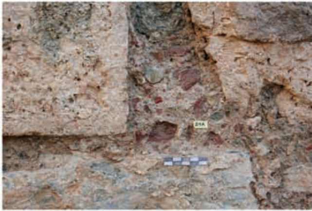
1 Antiker Mauermörtel des Bruchsteinmauerwerks im Bereich der Cella-Ostwand
