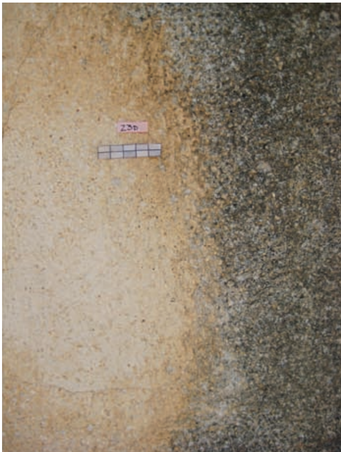
2 Auswaschung (dunkel) in Kontrast zu einer ursprünglichen Oberfläche
