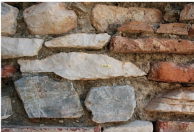
3 Hellgrauer Marmor des Bruchsteinmauerwerks
