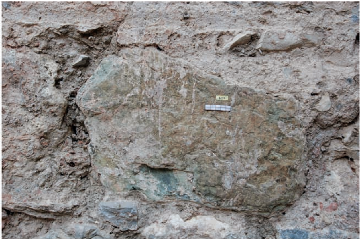
1 Serpentinblock im Mauerverband
