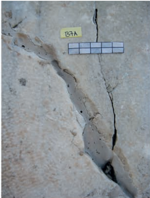
1 Marmorverklebung mit Polyester am Postament für die Statue Diocletians (0071)
