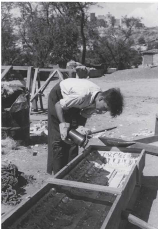
3 Übergießen des rekonstruierten Türsturzes aus Gips mit der Gummischmelzmasse VL 997
