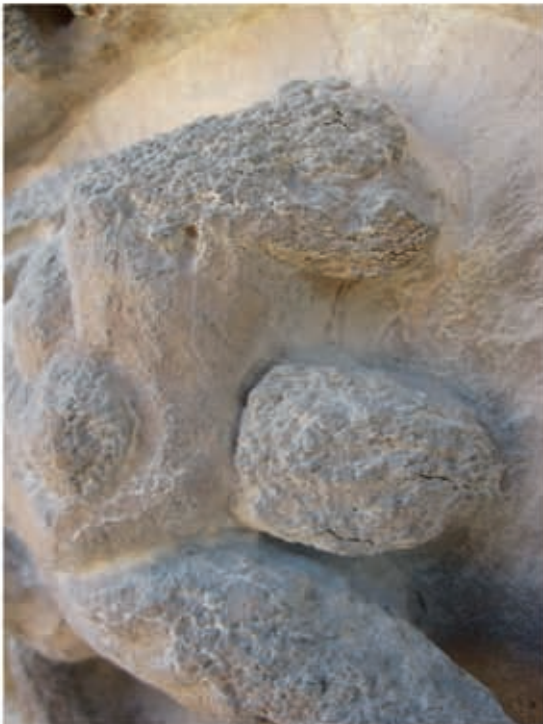
2 Rötliche Krustenbildung der Regenschattenzone über gestörtem Marmorgefüge (041F)
