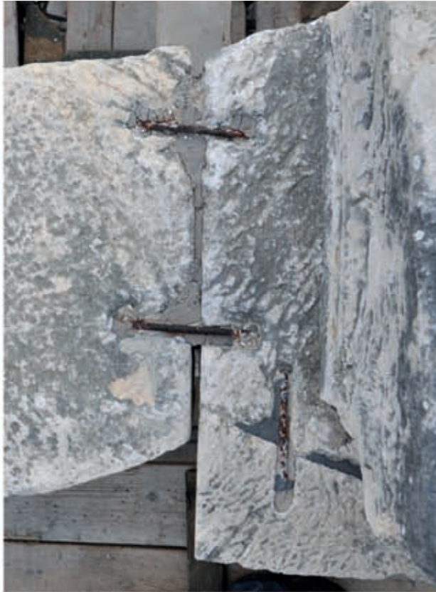
1 Verklammerung: Rundstahl an der Oberseite zwischen Block 051G und 052G
