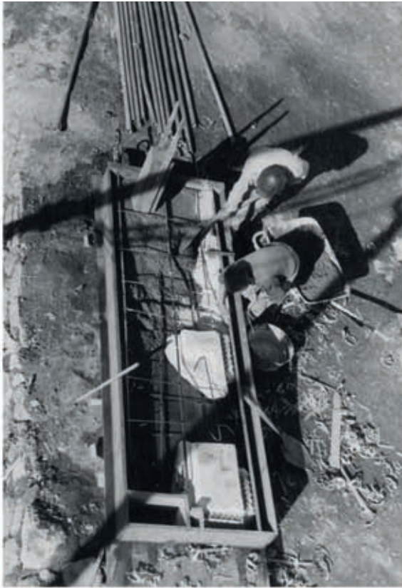
1 Herstellung der Türverdachung
