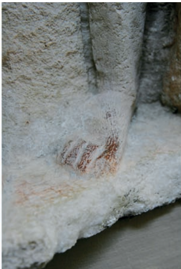
1 Friesblock 713: Verfärbung durch Handschweiß
