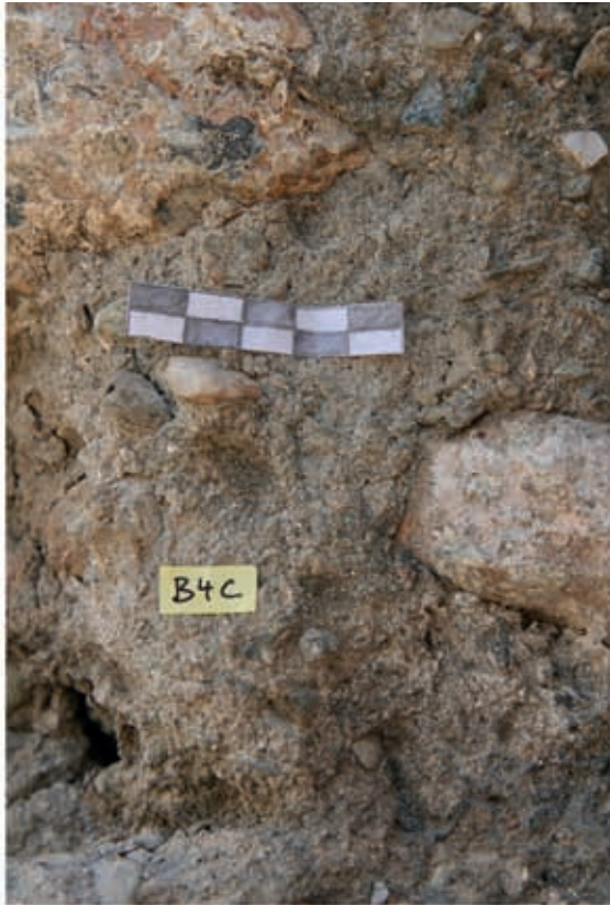
1 Eingebrachter Mauermörtel der Anastylose im Bereich der Cella-Südwand
