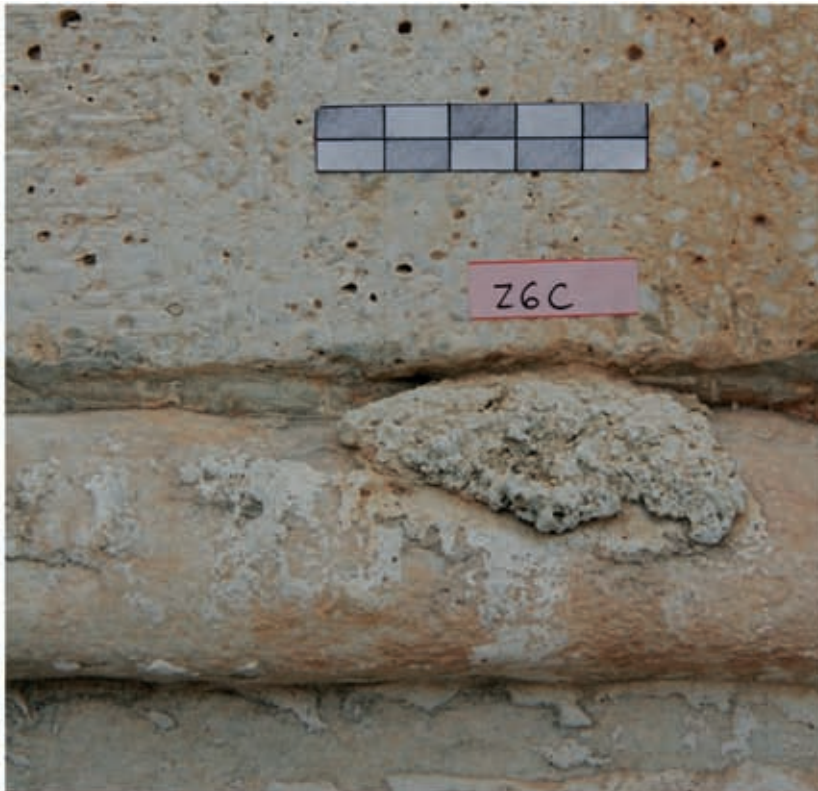
1 Mäanderband 070M : Mörtelrest auf der Oberfläche
