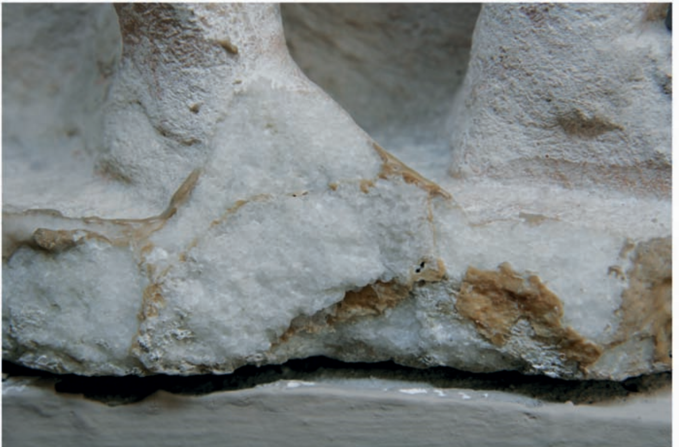
2 Ausbruch an der Unterkante von Friesblock 714 im Bereich einer Verklebung für den Wiederaufbau
