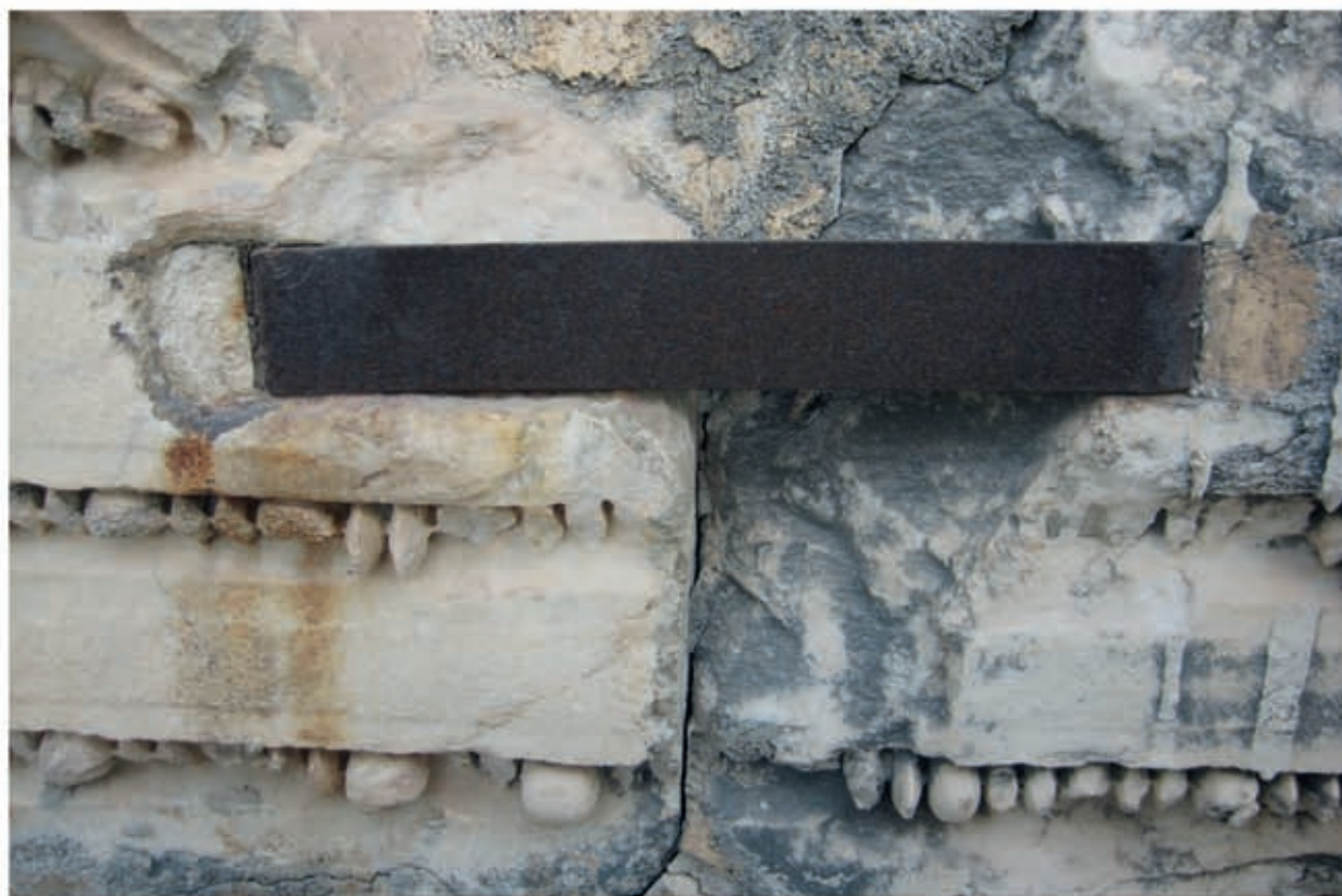
3 Verklammerung: Bandstahl zwischen 089A und 040A
