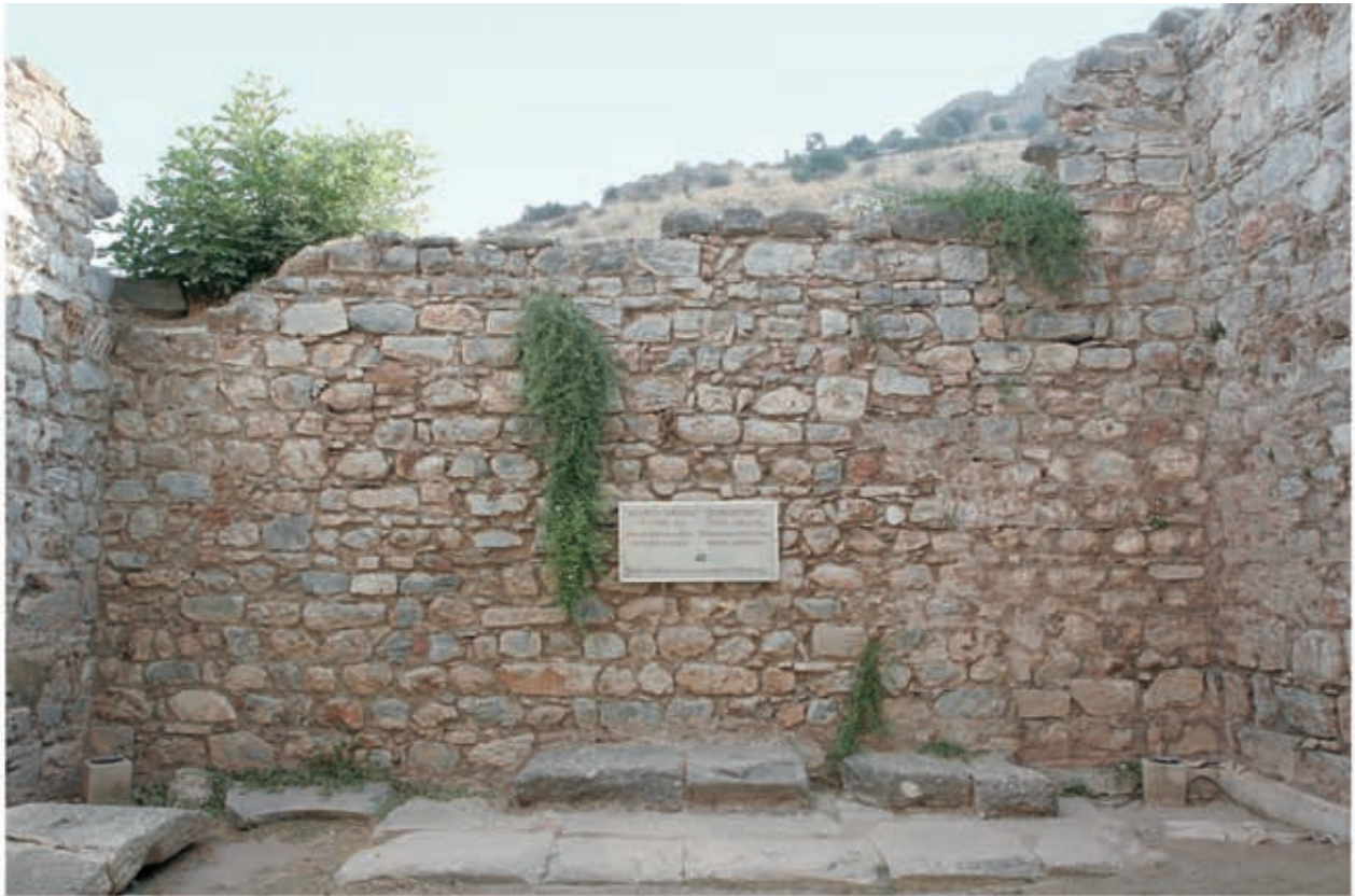
1 Wachstum höherer Pflanzen im Fugennetz des Bruchsteinmauerwerks
