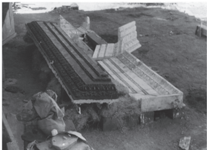
4 Herstellung der Abformung des Türsturzes: das Gipspositiv zeigt seinen Aufbau aus mehreren identischen Elementen
