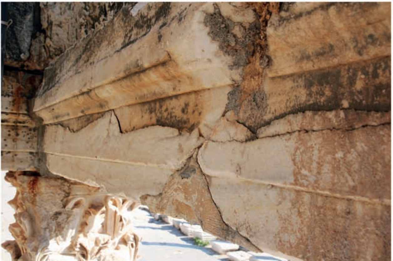
2 Architrav 040A : Schollenbildung über die gesamte Länge
