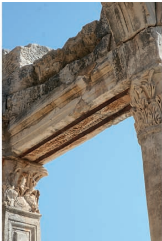
1 Architrav 040A (Unteransicht): Armierung in Form eiserner Feldbahnschienen
