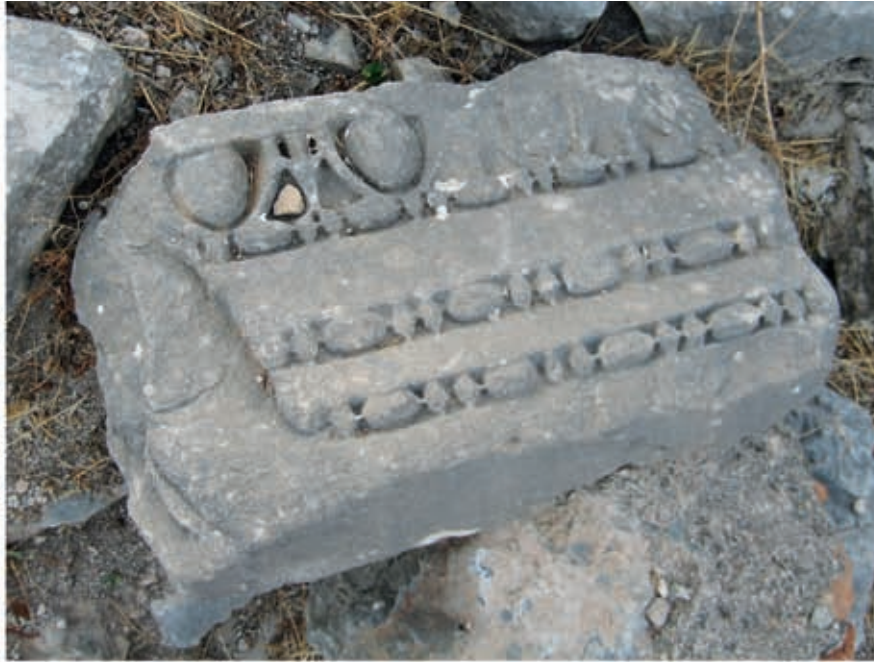
1 Frei exponierter Werkblock: deutliches Schadensbild durch Sonneneinstrahlung und Beregnung
