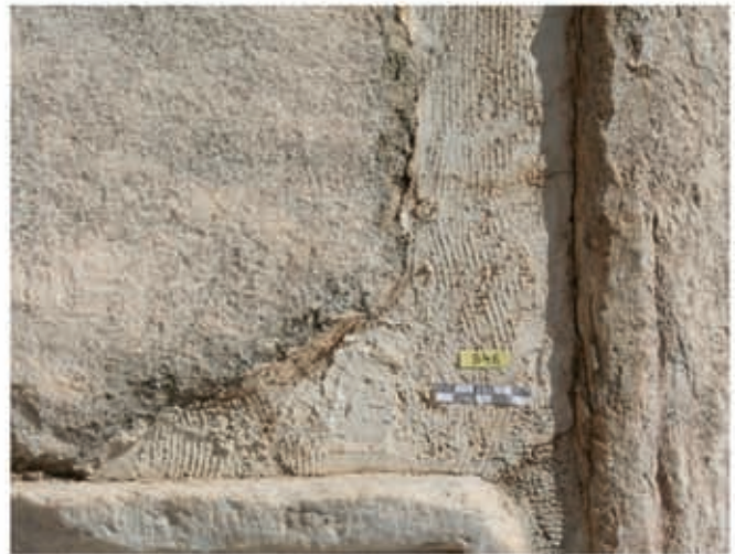
2 Fehlstelle, mit Restauriermörtel ergänzt
