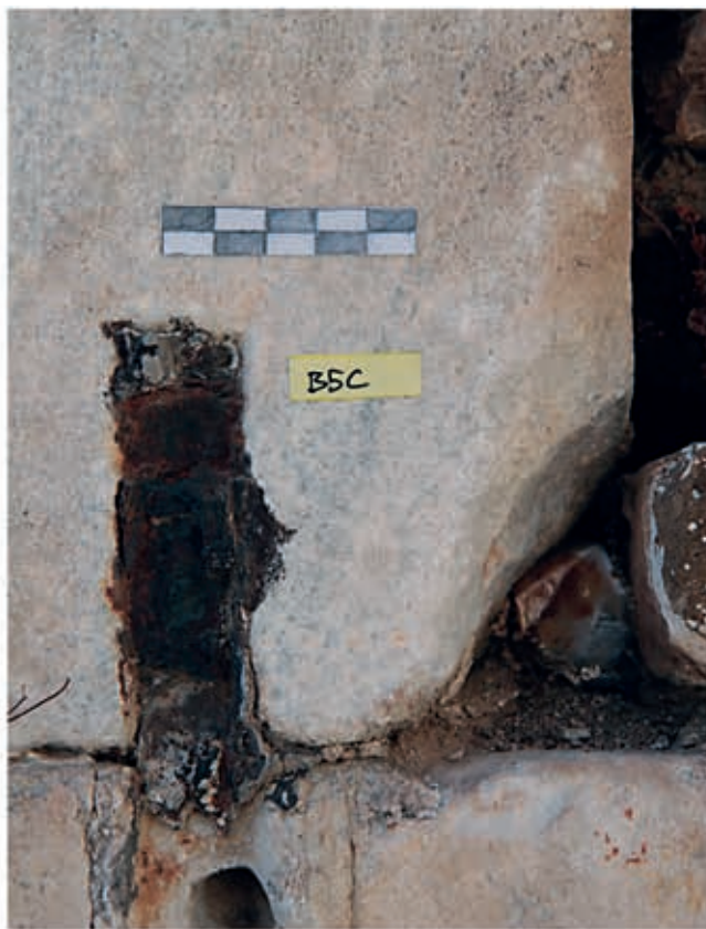
1 Eisenklammer mit Bleiverguss im Mauerwerk der westlichen Ante
