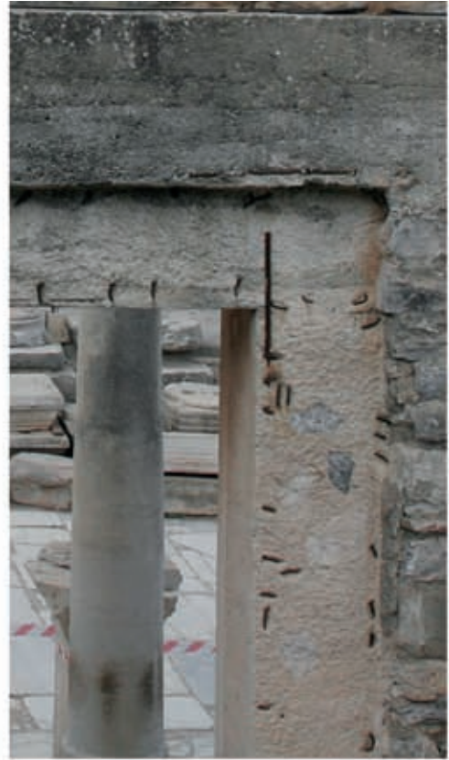
2 Sichtbare Bewehrungsseisen an der Rückseite der Türrahmung
