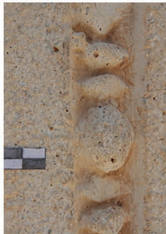
4 Detail der Türrahmung: Perlstab mit Zementhaut und angrenzenden Arealen mit überarbeiteter Oberfläche
